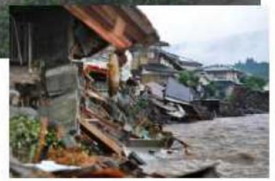
河岸侵食により家屋倒壊した状況
