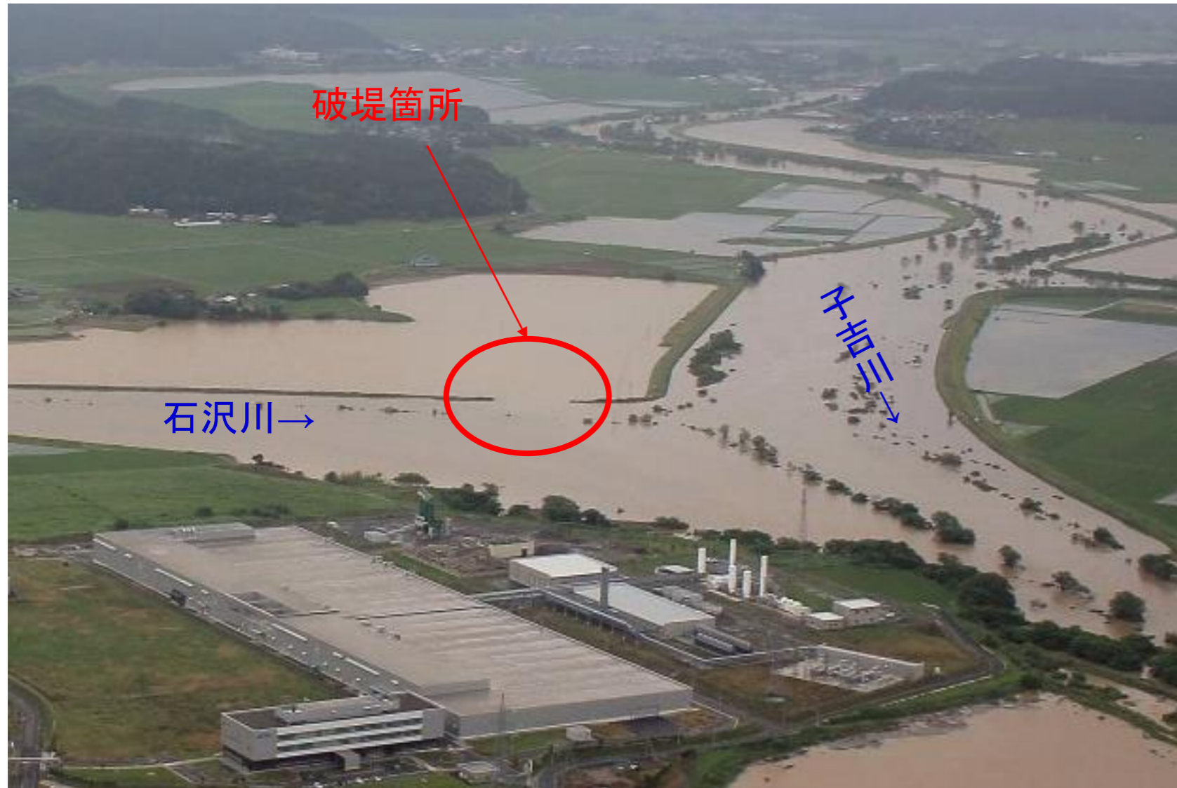
子吉川支川石沢川堤防の破堤状況(平成23年6月23日)
