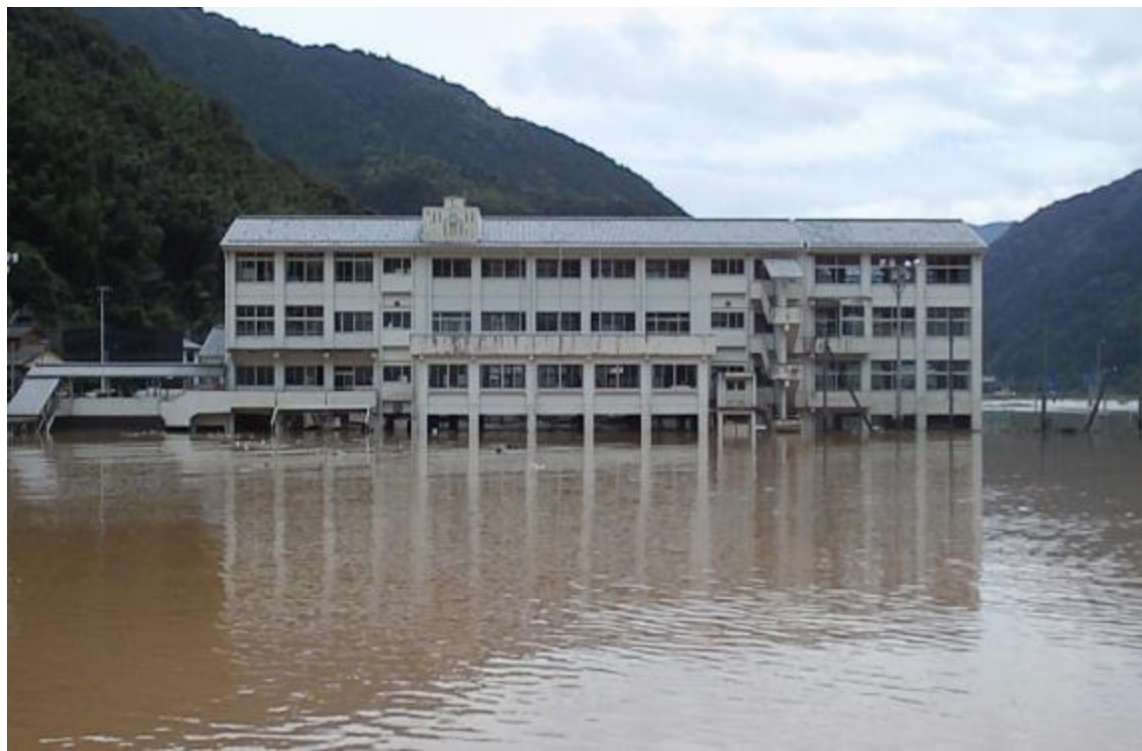
平成26年8月 避難所2階の浸水 (徳島県)
