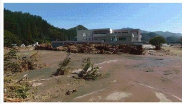
平成28年台風第10号による被害状況
