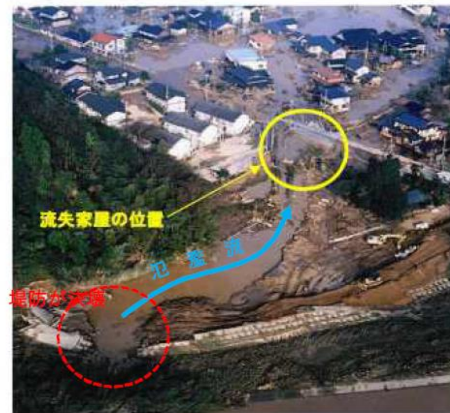
堤防決壊に伴い木造家屋が倒壊した状況
