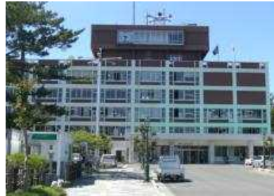
建築物の耐震診断・改修等
