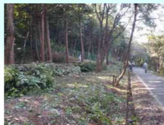
緩衝帯の整備
