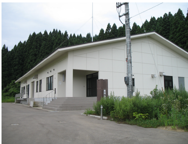
(設置された処理場)
