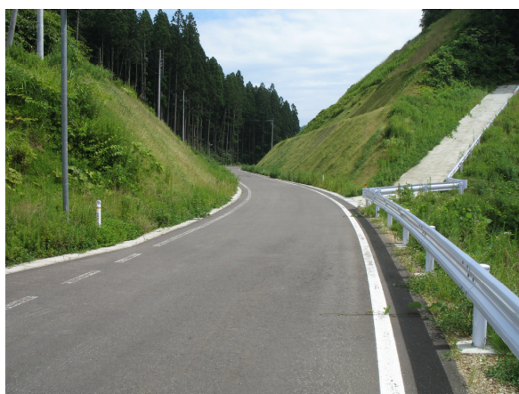
(整備された堀切雷田長坂線)
