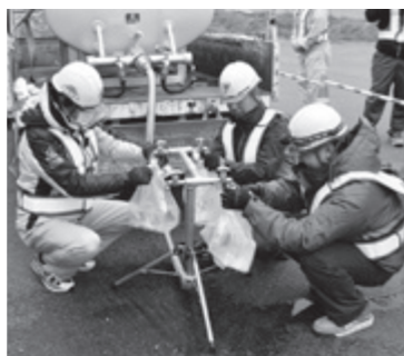
給水車からの応急給水作業
