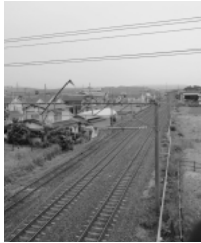
御門線橋から薬師堂方向の羽越本線
