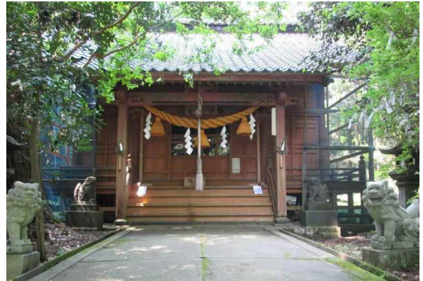
拝殿外観（向拝部）
