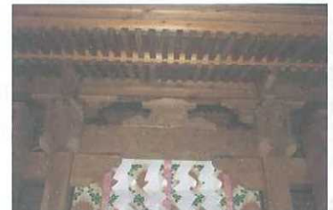
[本殿向拝廻り]
