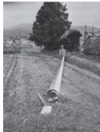
電柱が根元から折れ…
