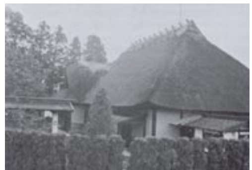
土田家も屋根に被害を受けた
