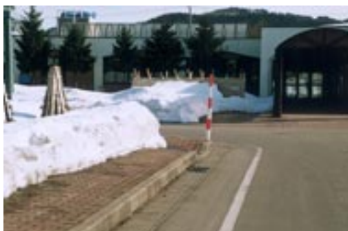
現在段差のある歩道を改善しています
