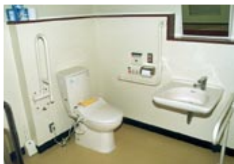
役場庁舎に新設された障害者用トイレ
