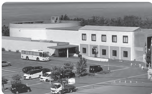
空調設備の修繕を進める岩城会館
