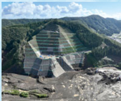
ダム右岸側 (基礎掘削完了)
