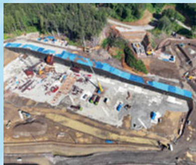
ダム施工設備
