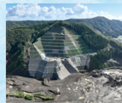
ダム右岸側 (基礎掘削完了)
