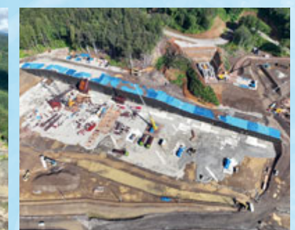
ダム施工設備
