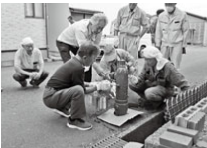
7月8日(水) ワンハウス(株)八日会 消火栓塗装奉仕作業
