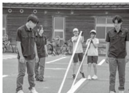
6月2日(火) 白線引き工事
