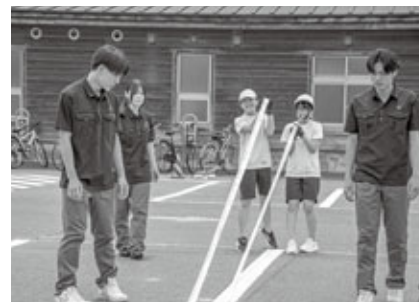
6月2日(火) 白線引き工事
