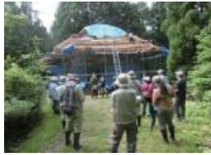
屋根葺替作業見学会(木境大物忌神社)
