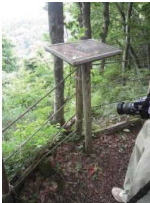
崖に面した部分の木杭とロープ
