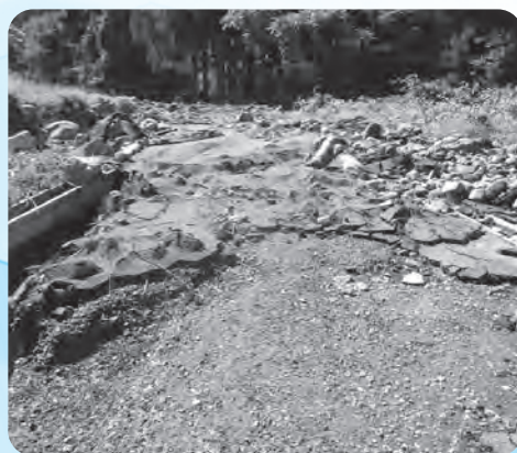
復旧が遅れている災害現場
