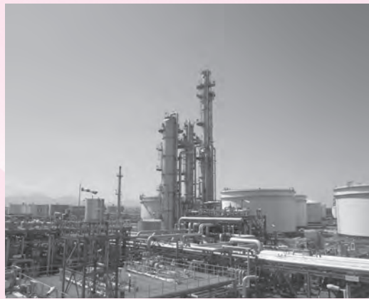
製油所で排出されたCO 2 を分離・回収する設備
