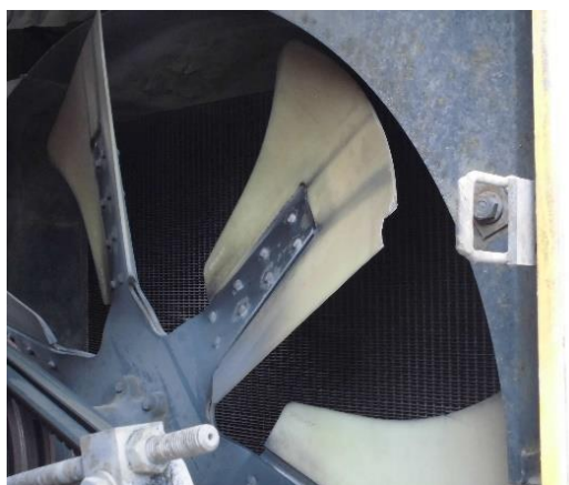
ラジエーターファン破損（欠け）
