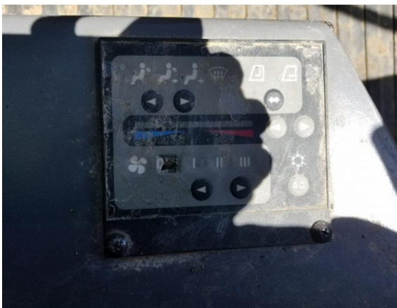
空調等操作ボタン類
