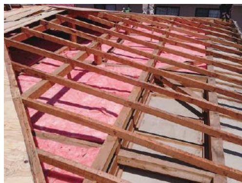
部分リフォームの例 屋根を張り替え時に天井断熱をおこなう。 (志村建設㈱提供)
