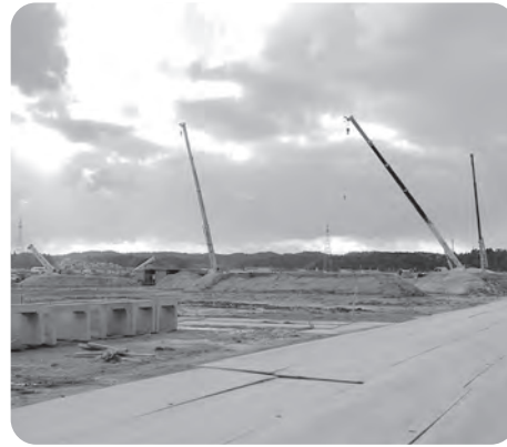
建設中の本荘東中学校区統合小学校
