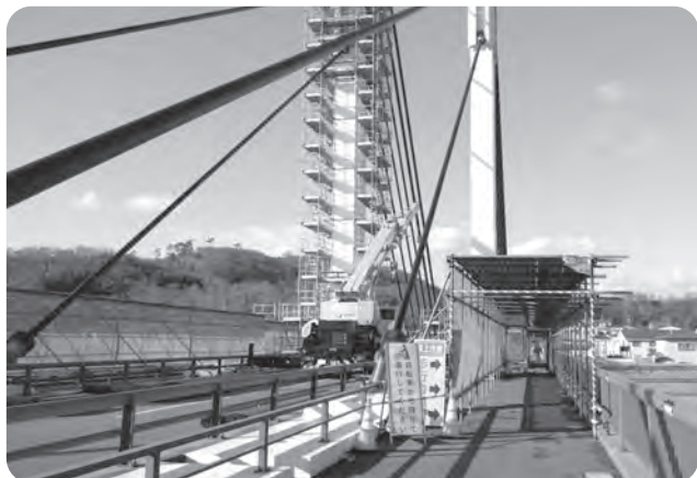
修繕が進む由利橋
