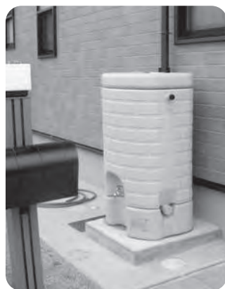
雨水貯留タンク
