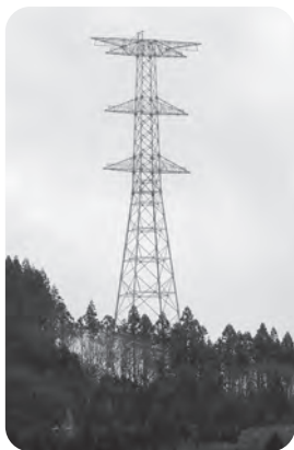
高規格高圧線の鉄塔
