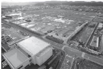
造成工事が進む本荘東中学校区統合小学校
