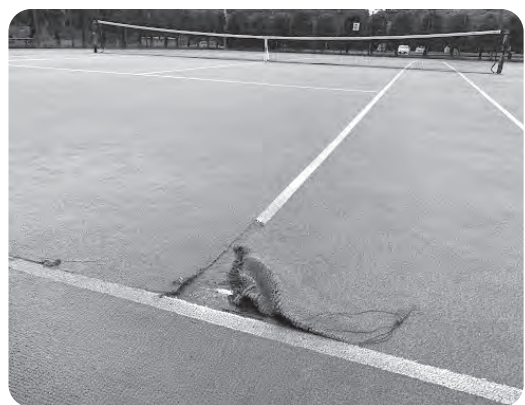
修繕前の水林テニスコートの状況
