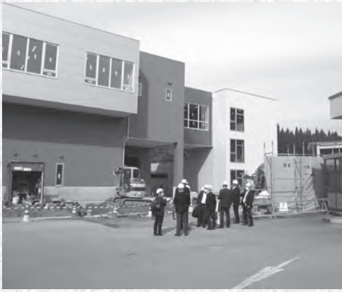
建設の進む建物も調査
