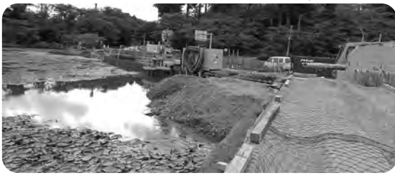
御手作堤の護岸掘削始まる
