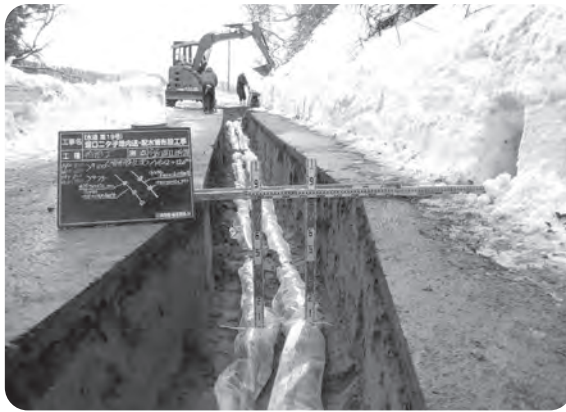
進む水道管の更新工事
