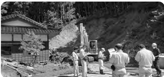
産業建設常任委員会による大雨被害の現地調査
