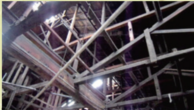
工場西棟の広大な屋根を支える洋風と和風の複雑な屋根の骨組み
