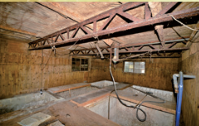
昭和32年建築の工場東棟旧諸味室のコンクリート枡槽
