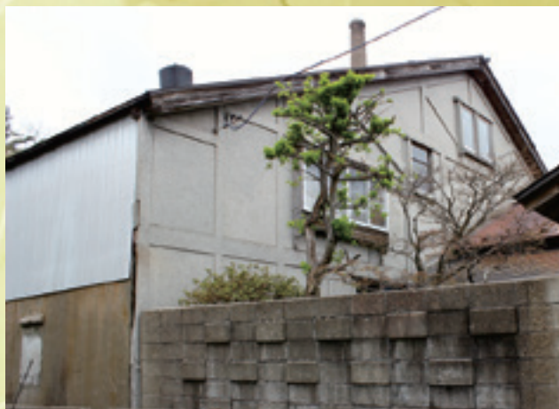
正面外壁の装飾が近代的な昭和前期建築の工場西棟
