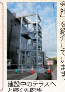
建設中のテラスへと続く外階段
