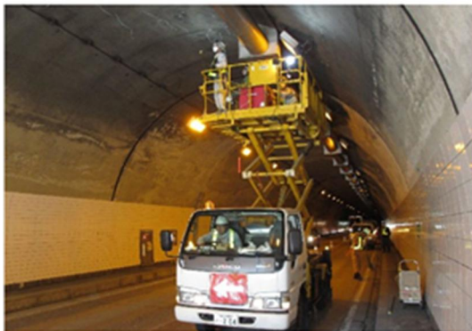
高所作業車による近接目視、打音検査
