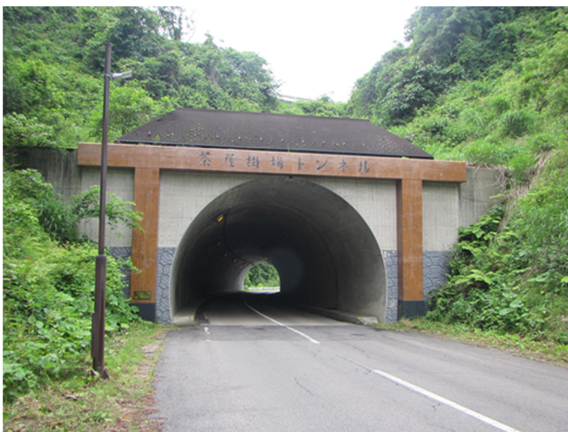
茶屋掛場トンネル（岩城地区）
