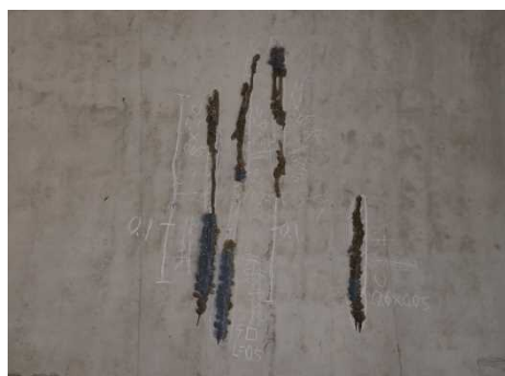
アーチ部のうき・鉄筋露出「Ⅲ」
