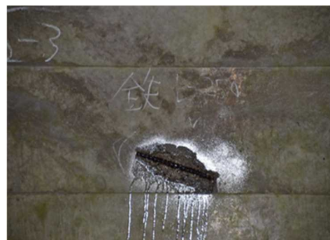
アーチ部の鉄筋露出「Ⅱa」
