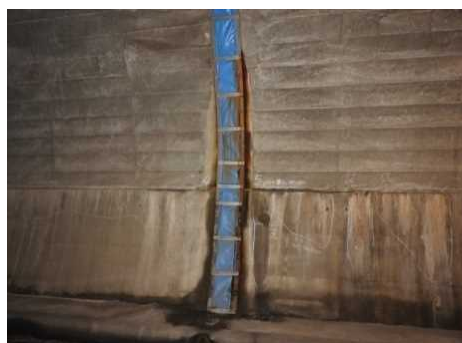
アーチ部の漏水（滴水～流下）
