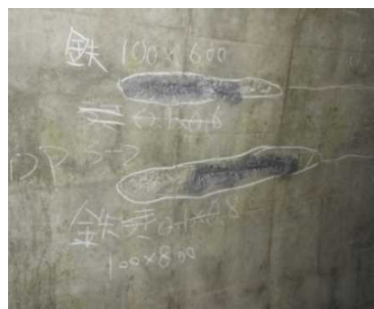
アーチ部の鋼材腐食
