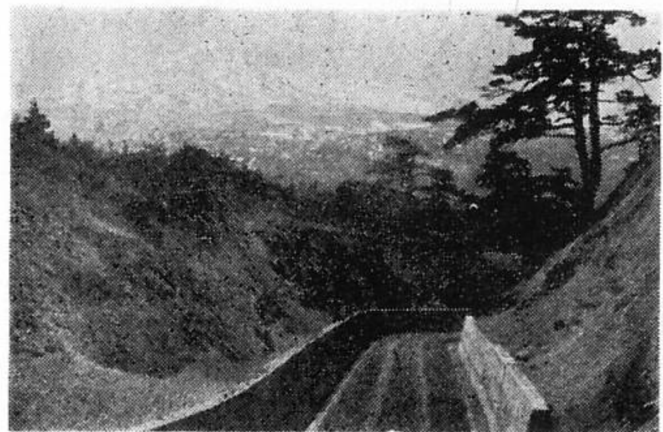
鳥海山を背景に、完成した林道
