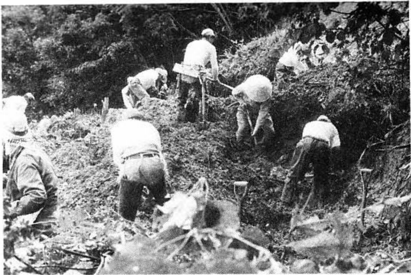
山腹崩落により埋没損壊した水路の復旧に当たる受益者たち。(須郷田ゼキで)
