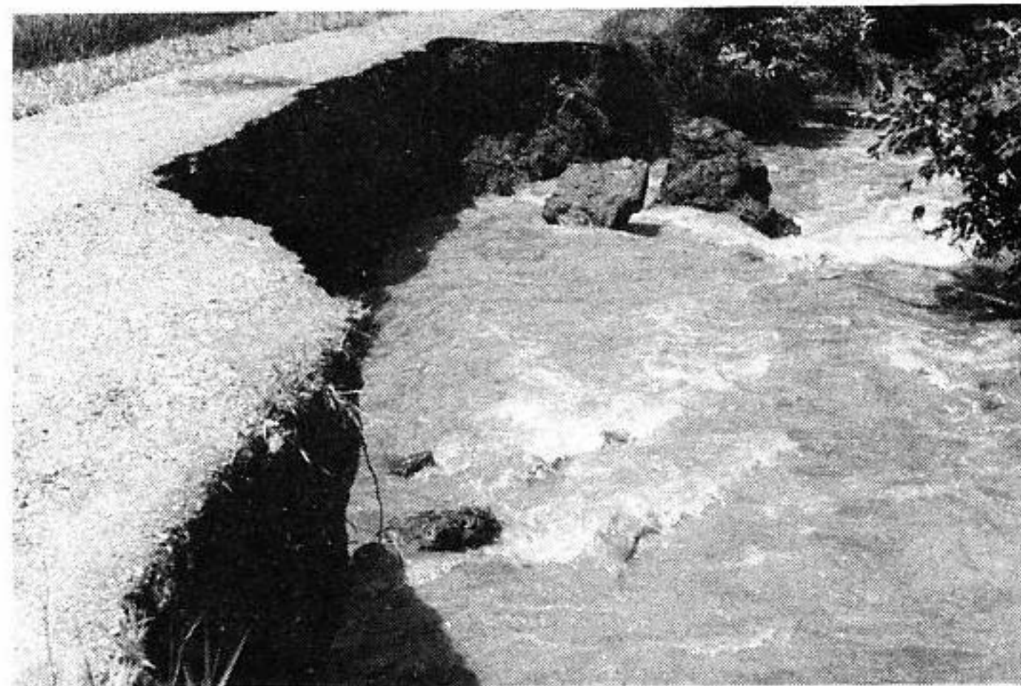
国・県道、町道を問わずこうした道路の損壊は町内随所で発生した。(祝沢地区で)
