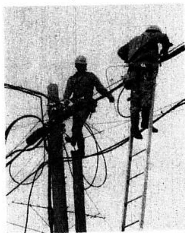
急ピッチの電話自動化工事
