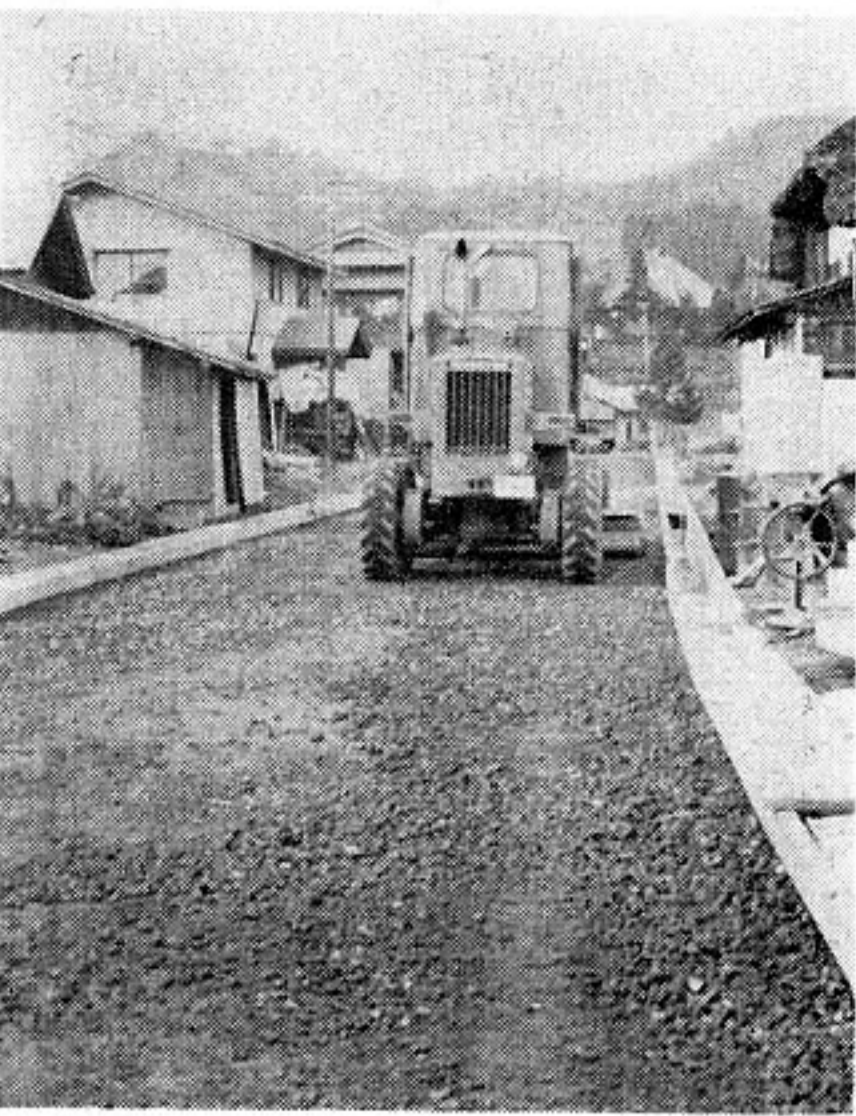
着実に進む町内の道路改良(蔵上里線で)
