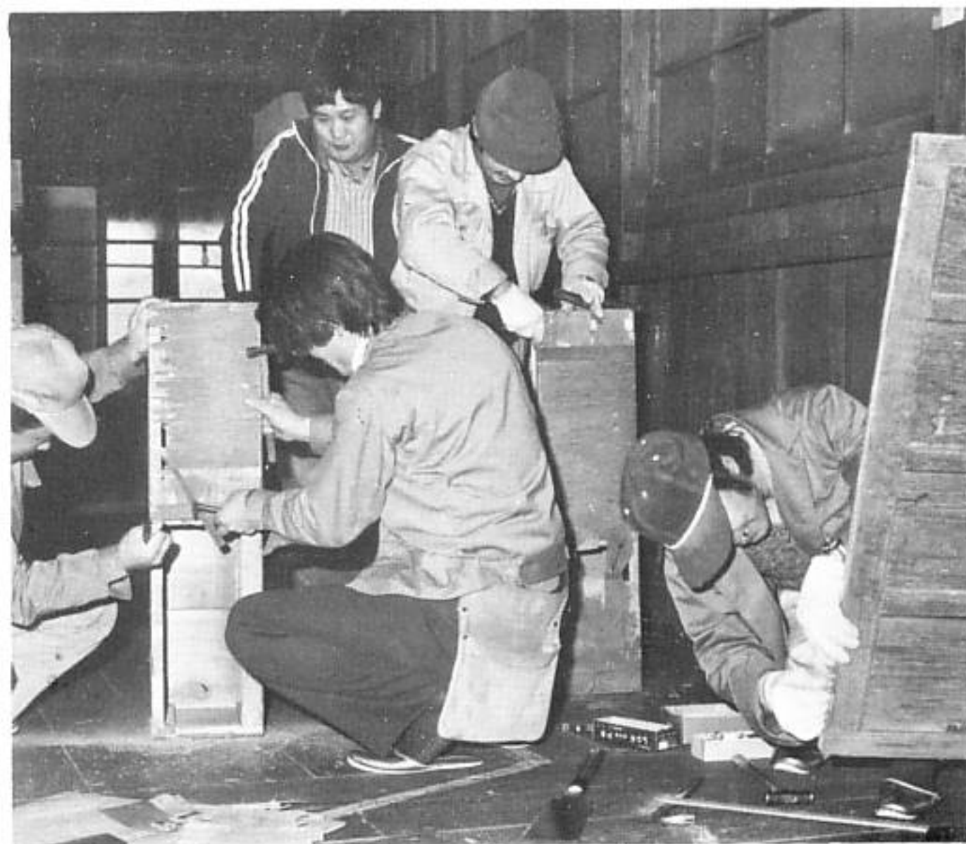
修繕作業は手ぎわよく行われた
