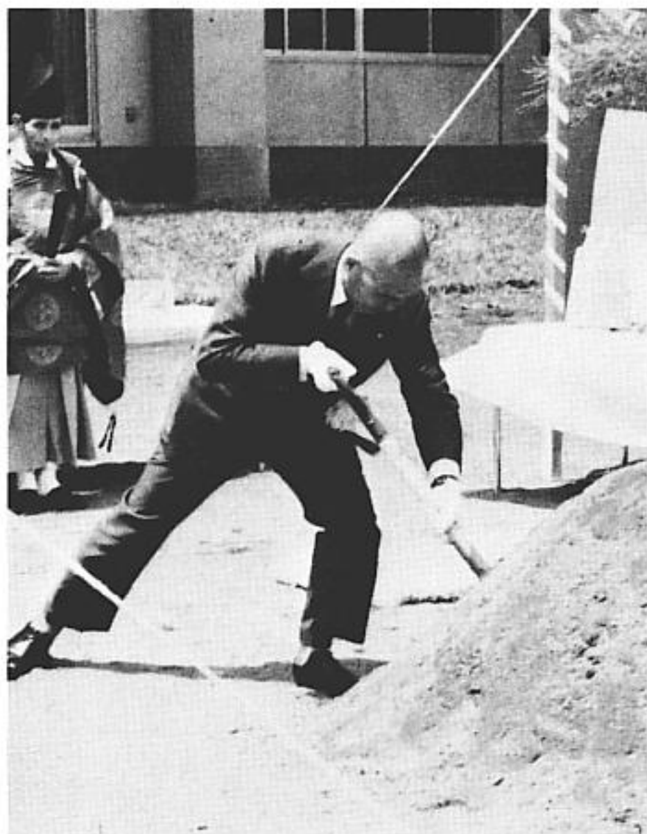
⇒ 工事の安全を願い鍬入れする小松町長
