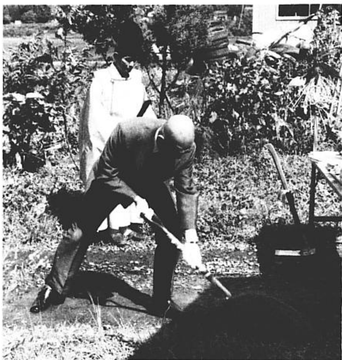
工事中の安全を祈り鉄入れする小松町長
