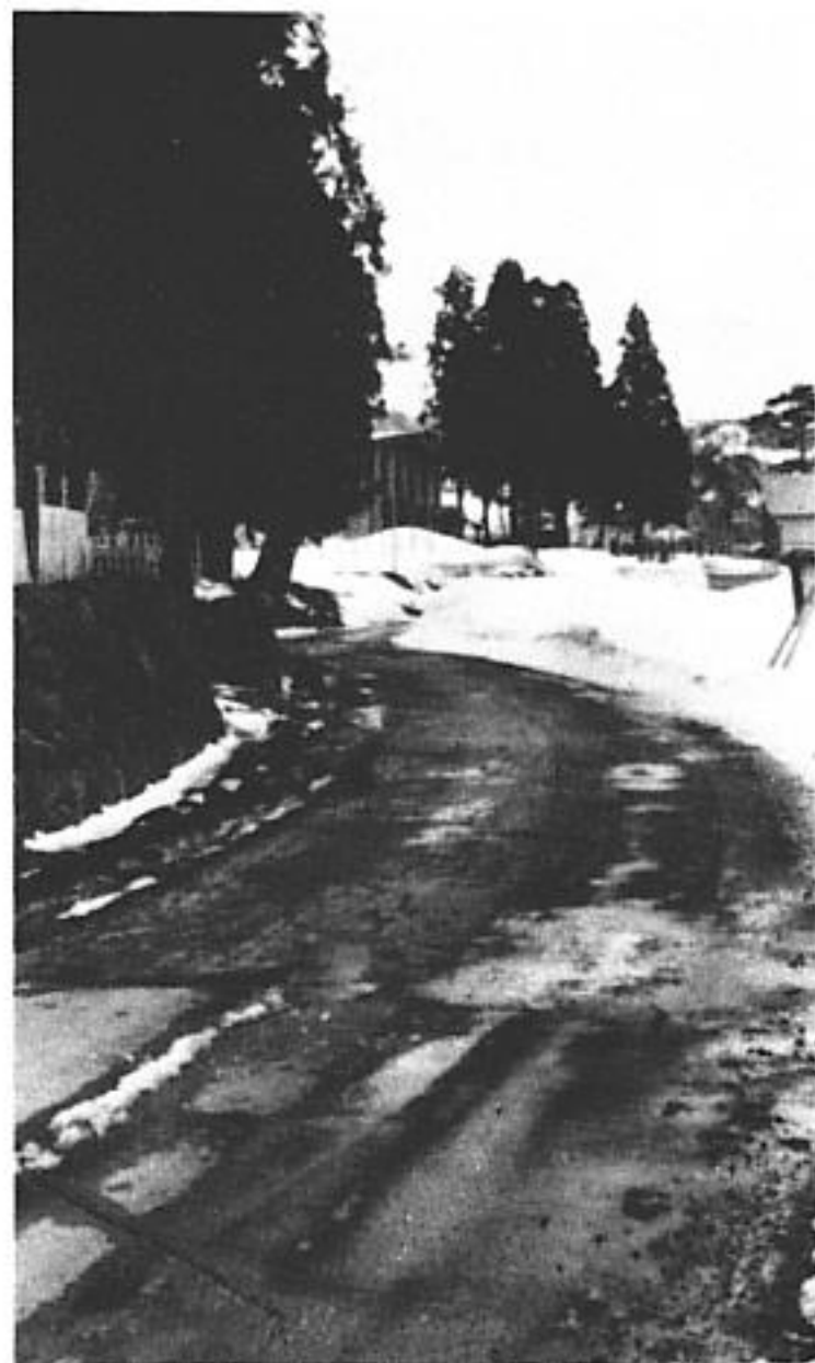
地下の沢～黒淵間の旧県道敷は町道野中線に
