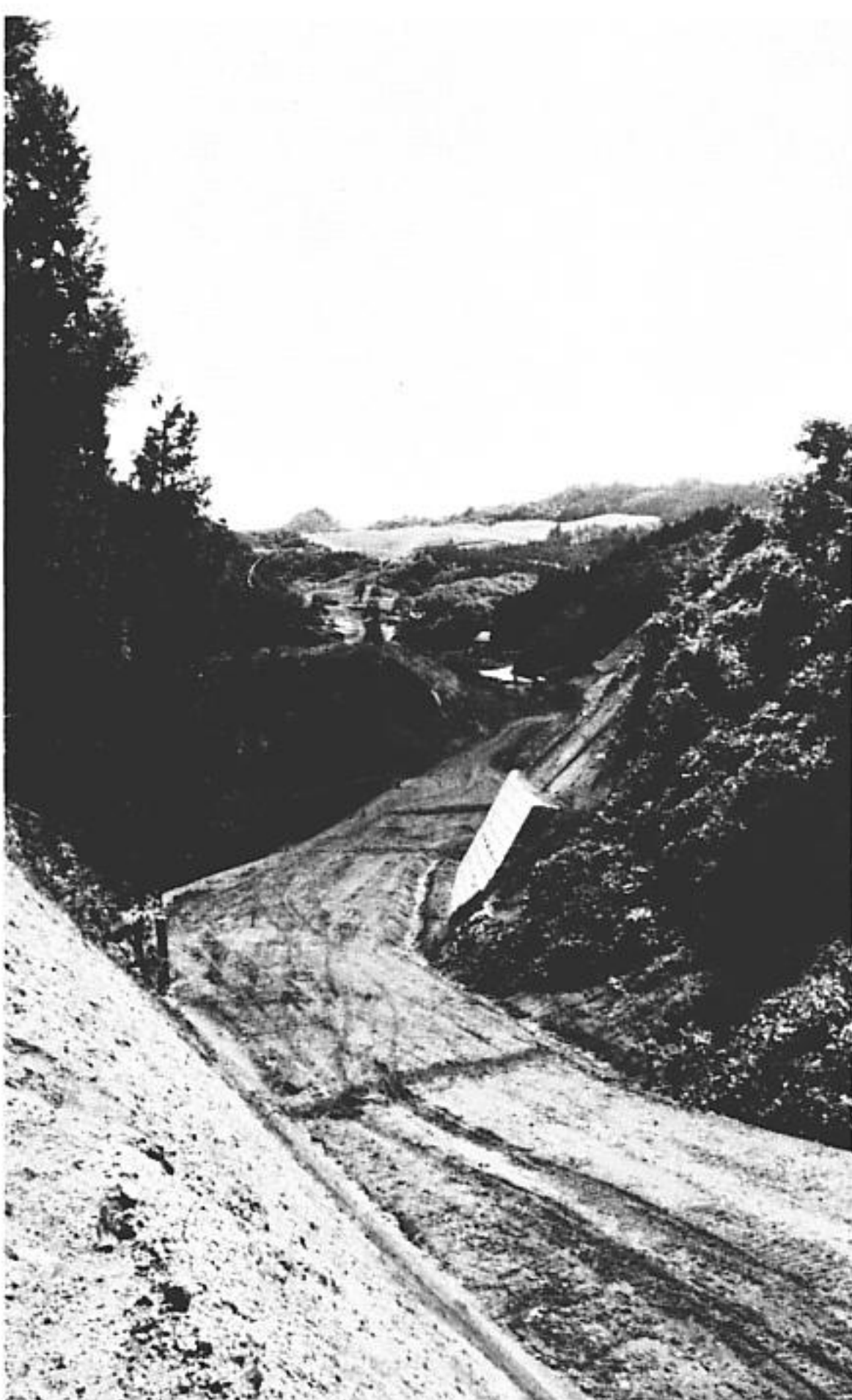
集落内の幹線路として大きな期待が寄せられている大台線改良工事（大谷地地内）
