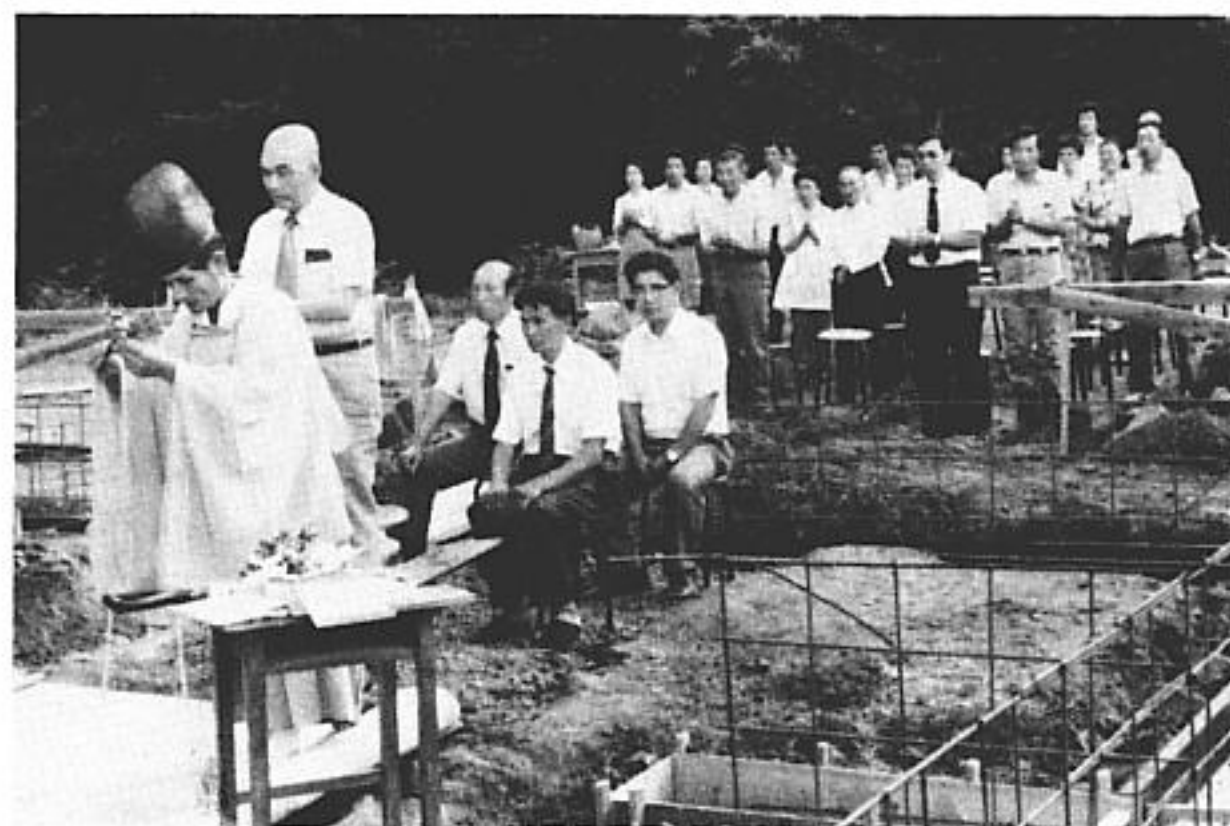
待望の会館建設——地鎮祭を行い工事の安全を祈る関係者
