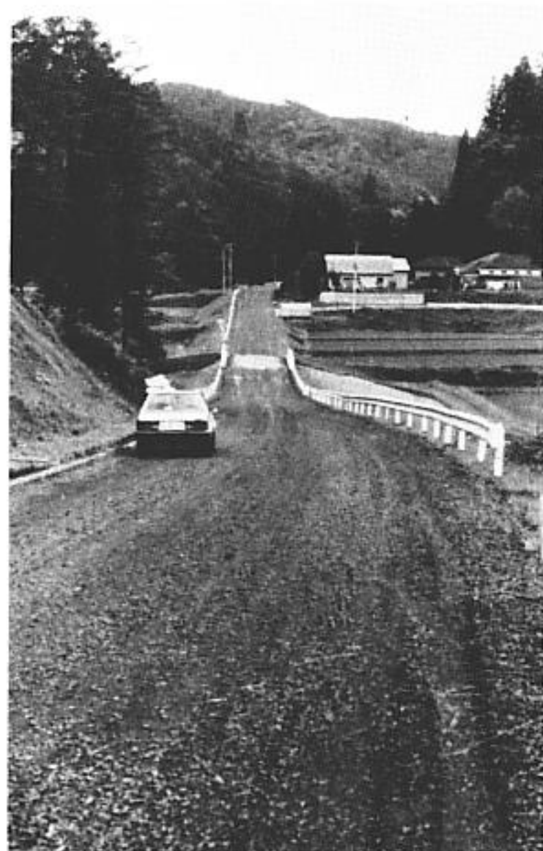
今年舗装される金山線の杉森地内
