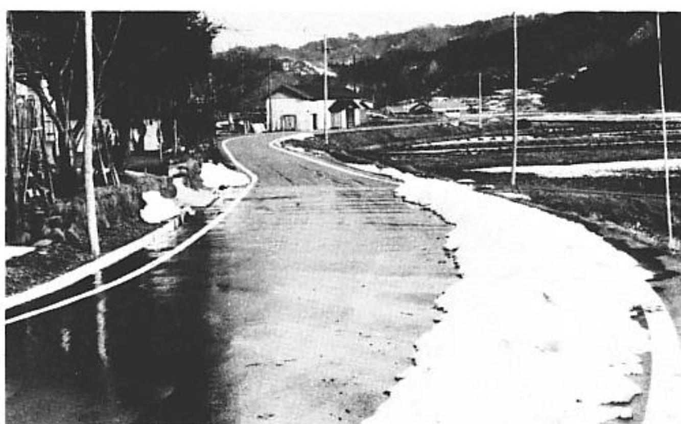
↑〈町道時雨山線〉 55年度に改良した時雨山地内359.75mは、654万円で舗装。全幅5m、車道幅員4.5m。
