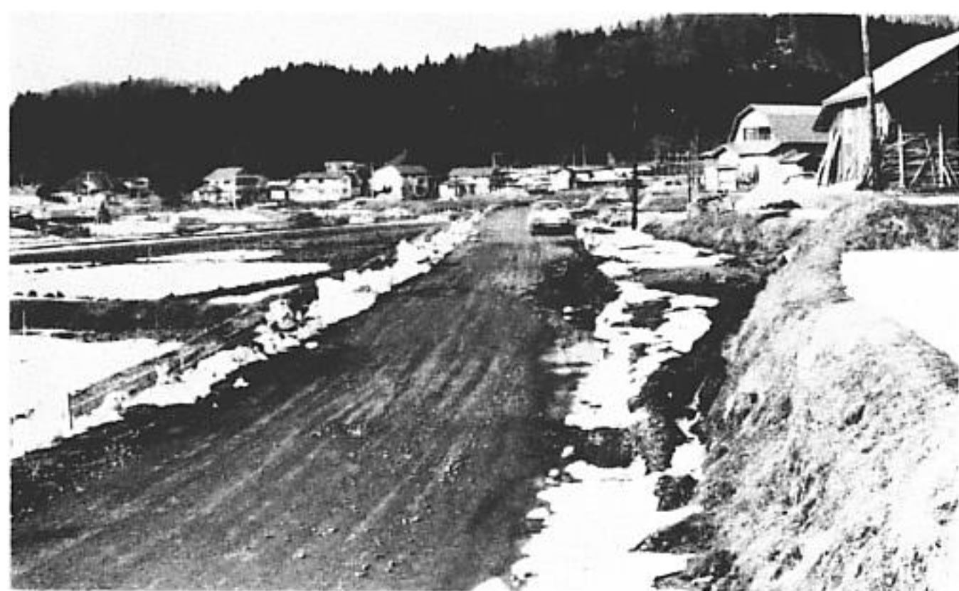
↑〈町道地下の沢線〉 地下の沢と黒淵を結ぶ206.2mは、335万円で、全幅5.5m、車道幅員4.5mに改良。57年度に舗装の予定。
