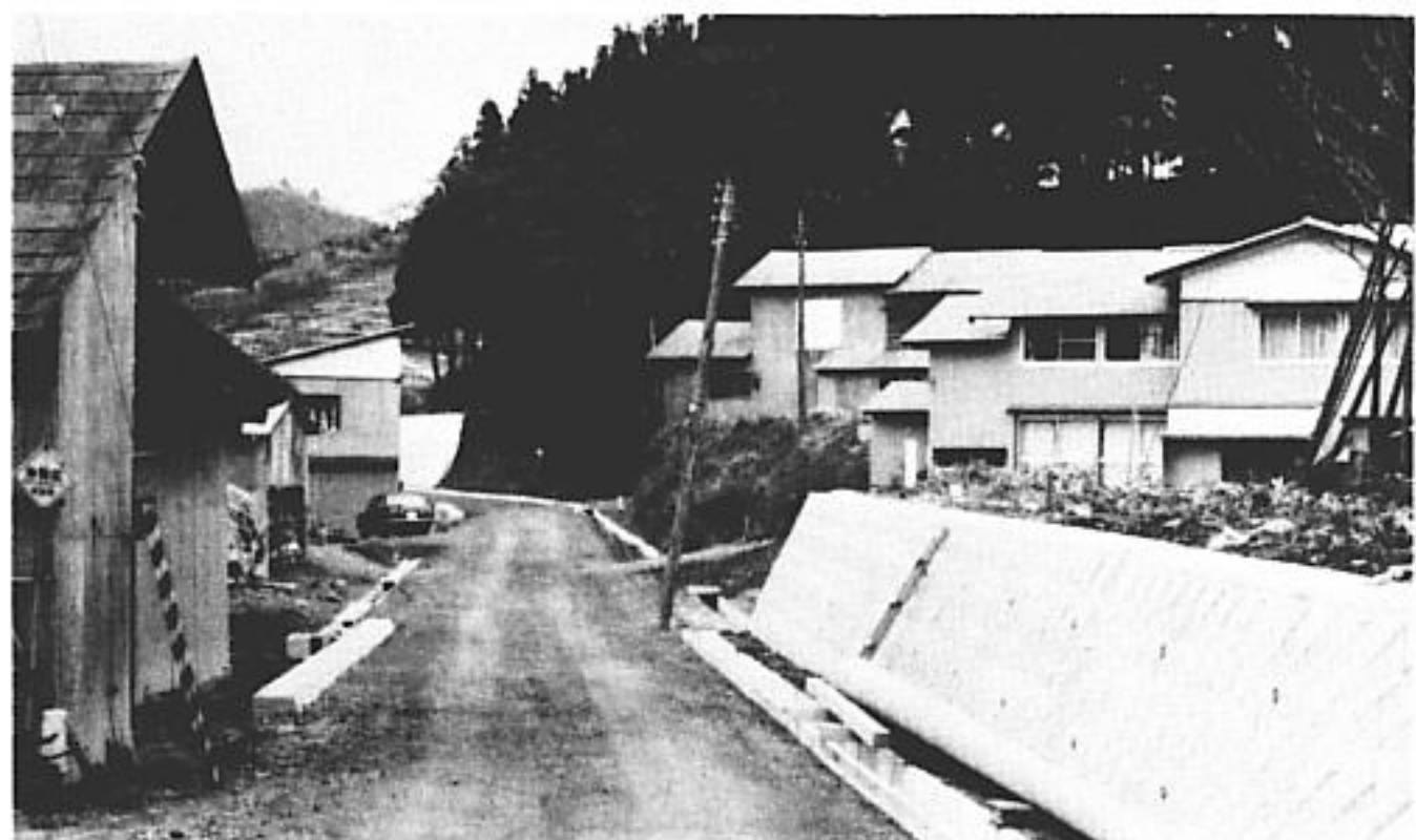
↑〈宮の下線〉 大琴の宮の下地内180mは、ミニ総パ事業で、全幅4m、車道幅員3mに改良。事業費は770万3千円、うち70%が国・県の補助。57年度に舗装の予定。
