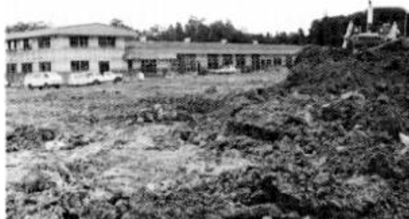
外構工事も急ピッチですすすめられている
