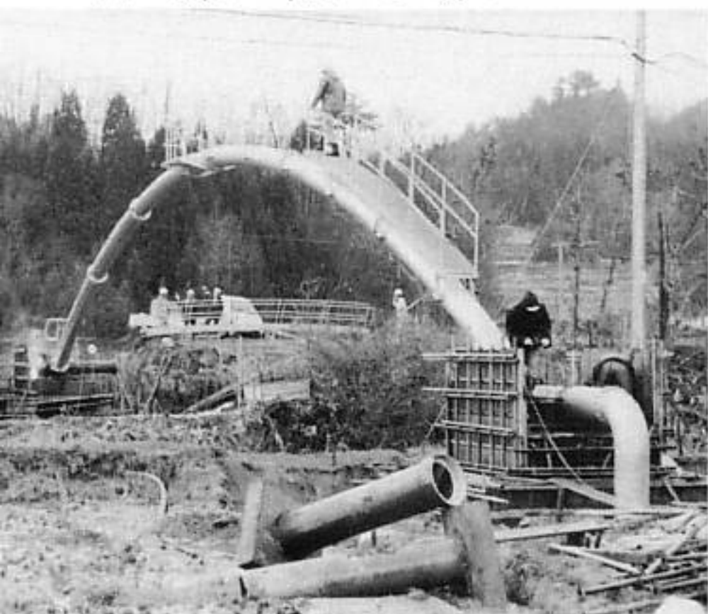
虹ならぬ法内地区への水のかけ橋「水管橋」が岩館下の高瀬川に渡され、水道拡張事業もいよいよ大詰め
