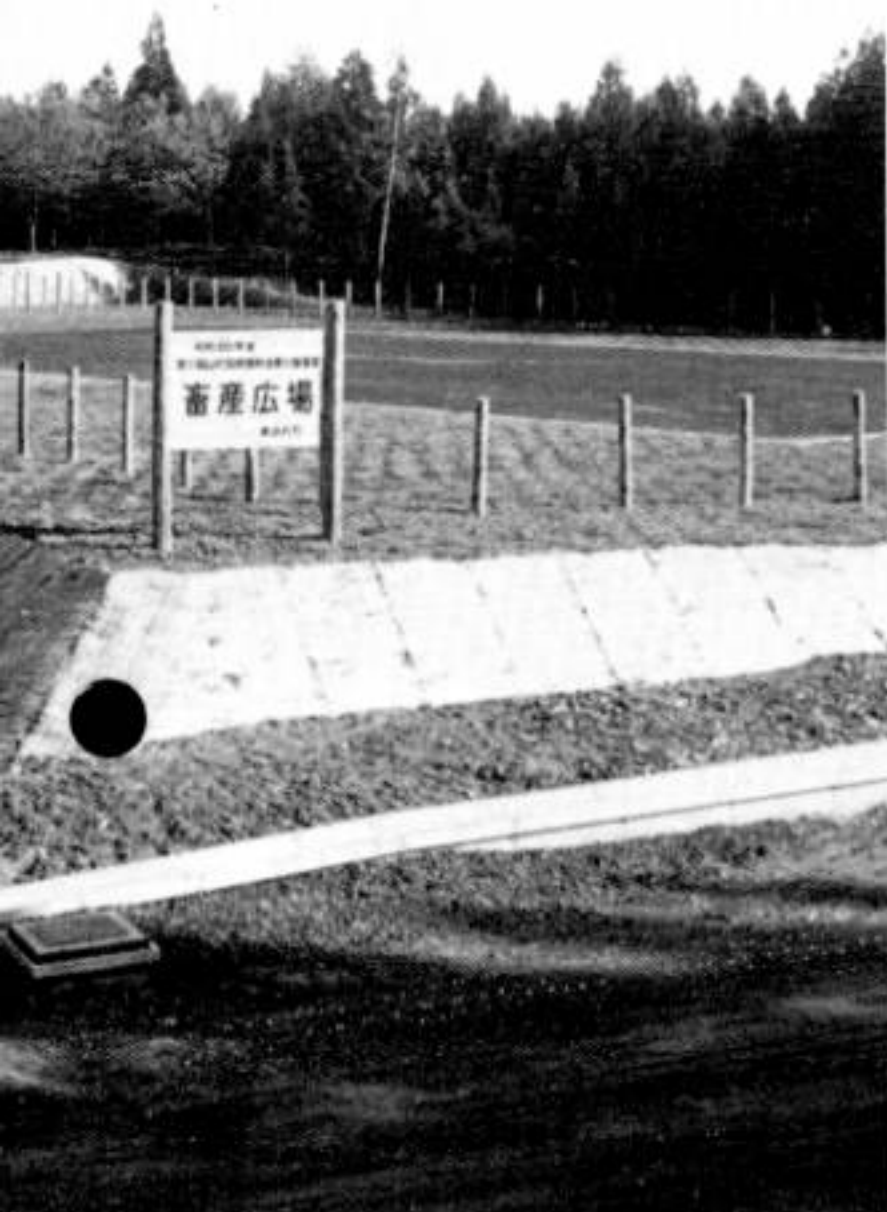
畜産広場を建設
