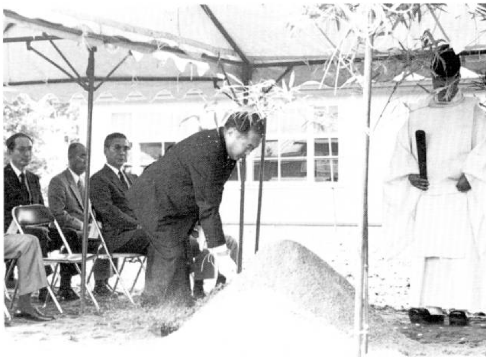
特養ホーム建設に着手（地鎮祭・7/2）
