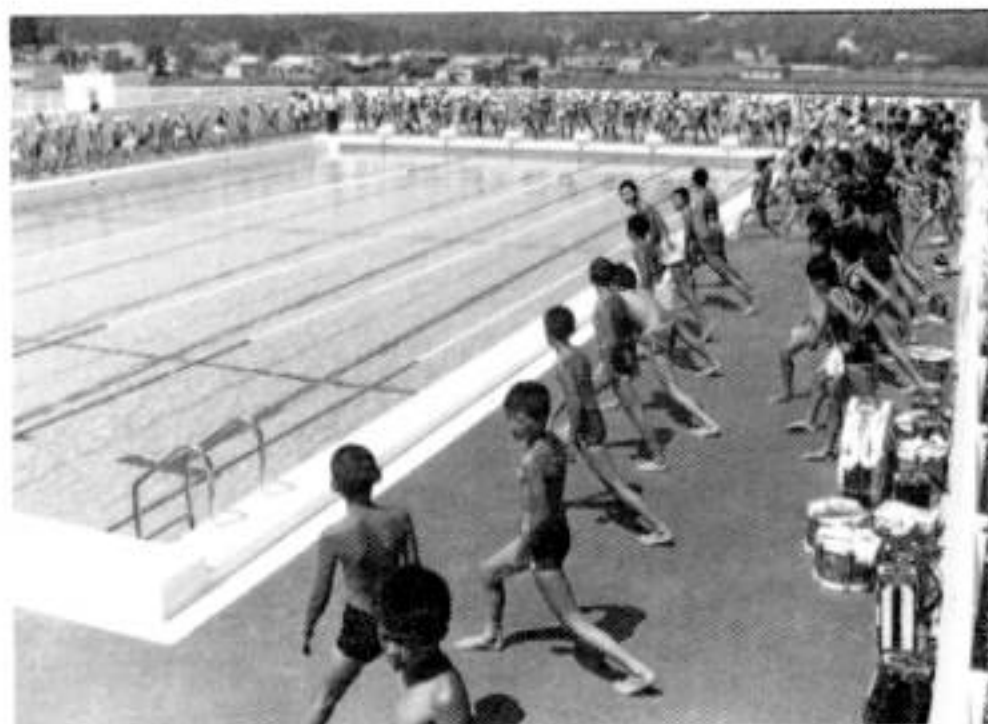
高瀬小にプールを建設（プール開き・8/10）
