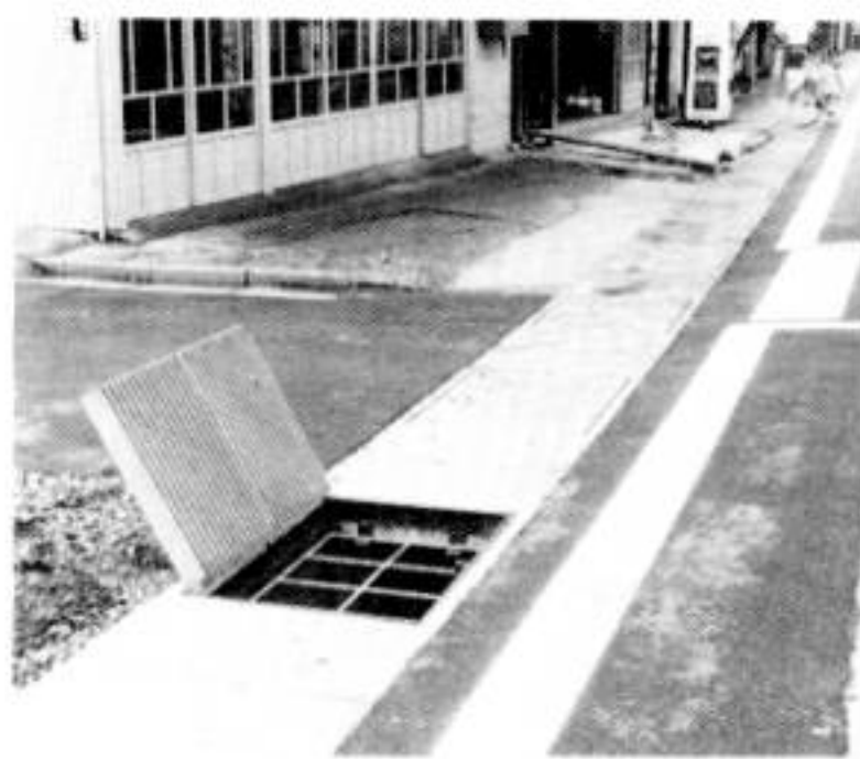
このほど完成した蔵地区の流雪溝
