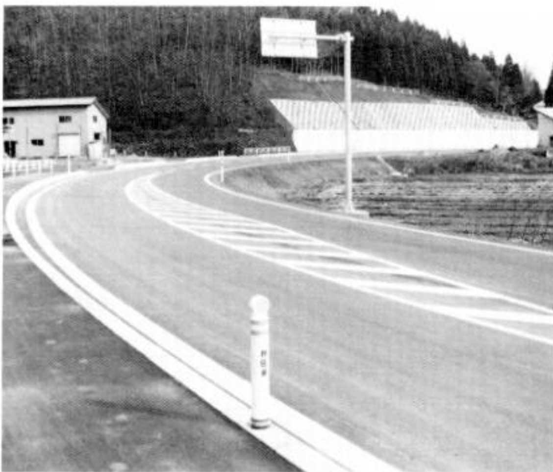
仁賀保矢島館合線の田代バイパスが完成
