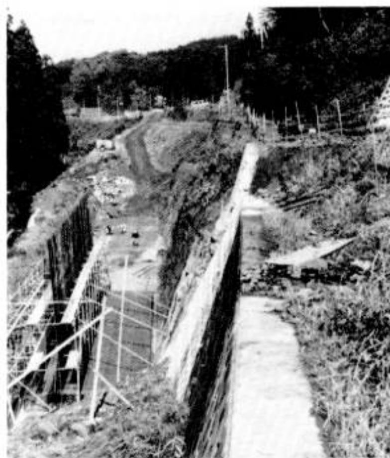
よう壁工事を施工中の松沢地内
