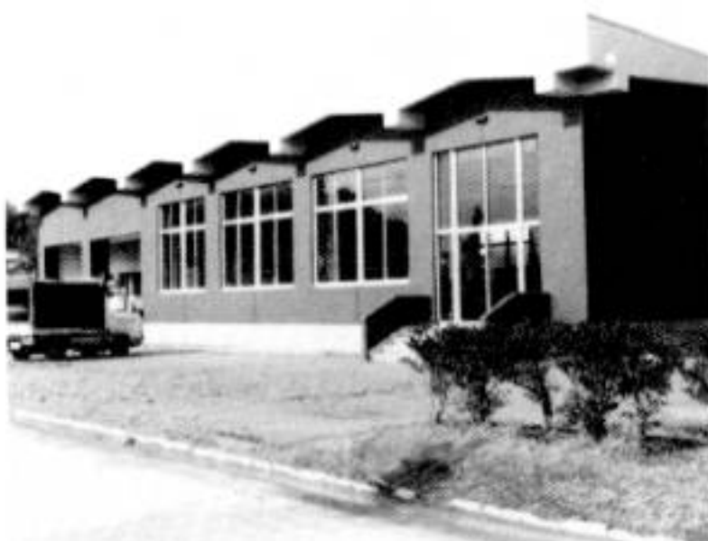
完成した東中の給食棟
