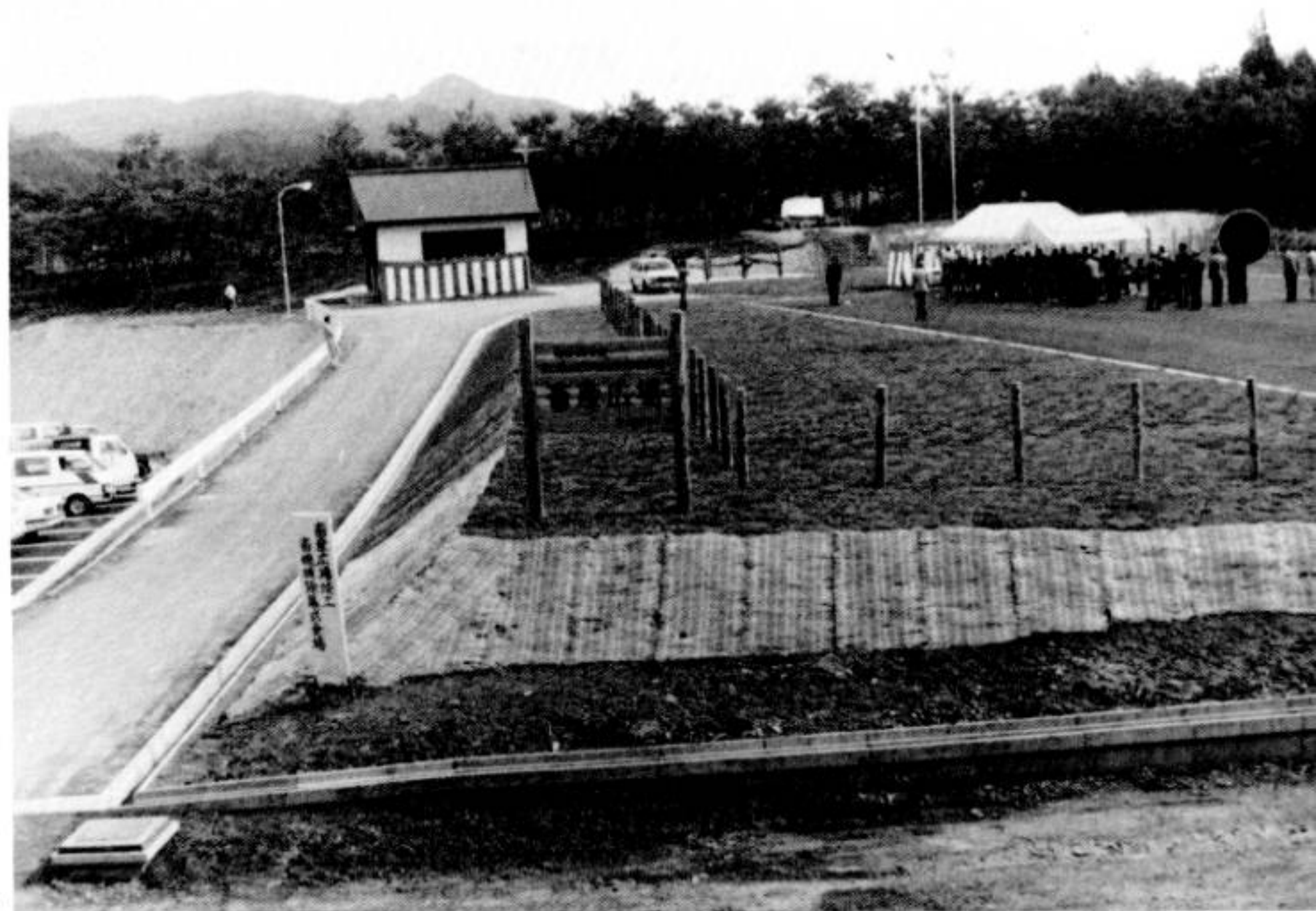
完成した畜産広場全景(竣工式にて)
