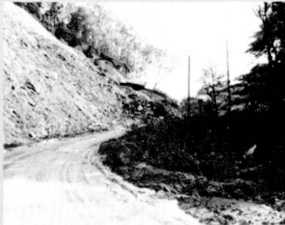
八沢木地区(高村線)は高村地内(樽水)を工事中
