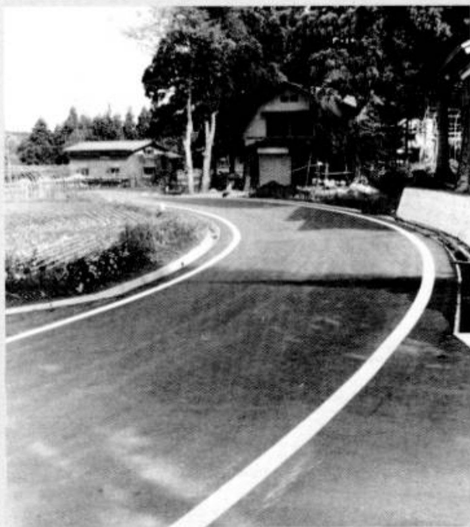
完成した向田線(向田地内)
