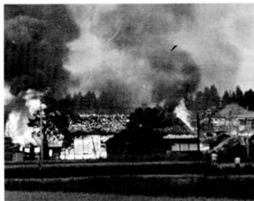
燃える旧方小（体育館側）
